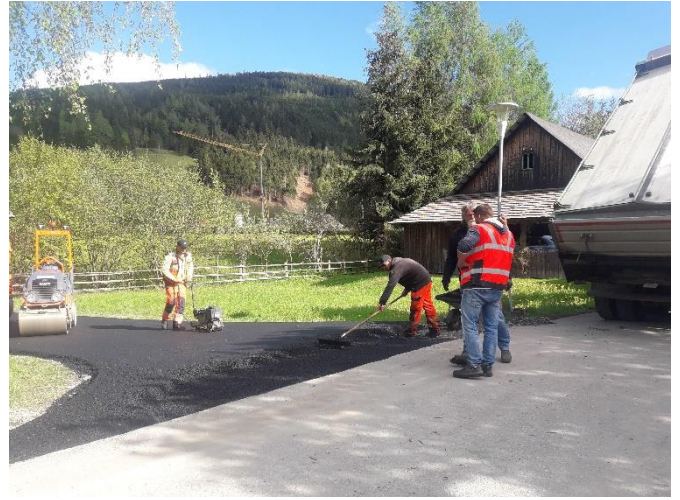
....und die fertige Einfahrt in die Steindorfsiedlung.
