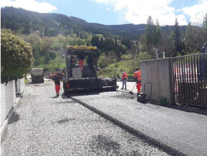
Neue Asphaltdecke in der Sägewerkstraße...
