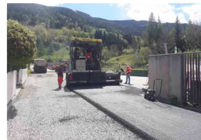
Neue Asphaltdecke in der Sägewerkstraße...
