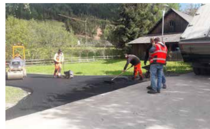
...und die fertige Einfahrt in die Steindorfsiedlung.
