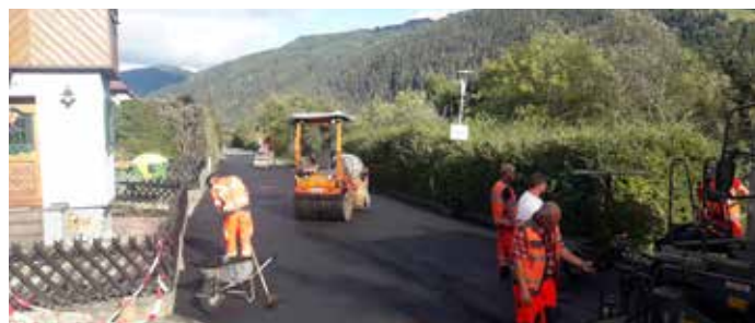
... und die fertige Asphaltierung in der Brandsiedlg.
