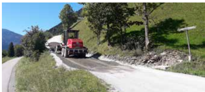
abschließende Graderarbeiten am Pichl...
