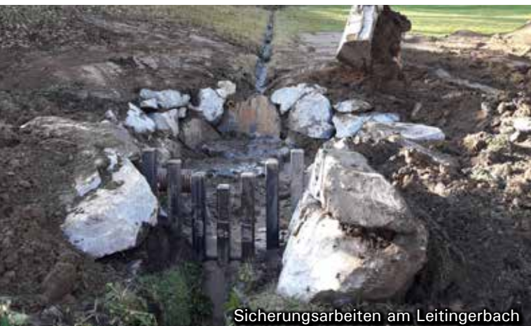
Bauhofmitarbeiter bei der Sanierung eines Durchlasses
