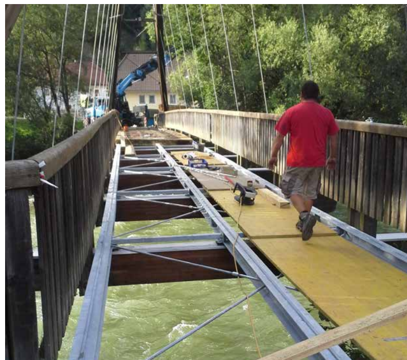
Sanierung Radwegbrücke in Stadl
