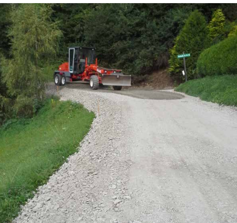
Graderaktion 2016 - Sanierung Gemeindewege
